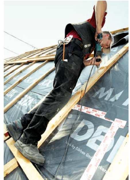
Die Konterlattung wurde bauseits auf der Dämmung gekrümmt und mit langen Doppelgewindeschrauben befestigt.
